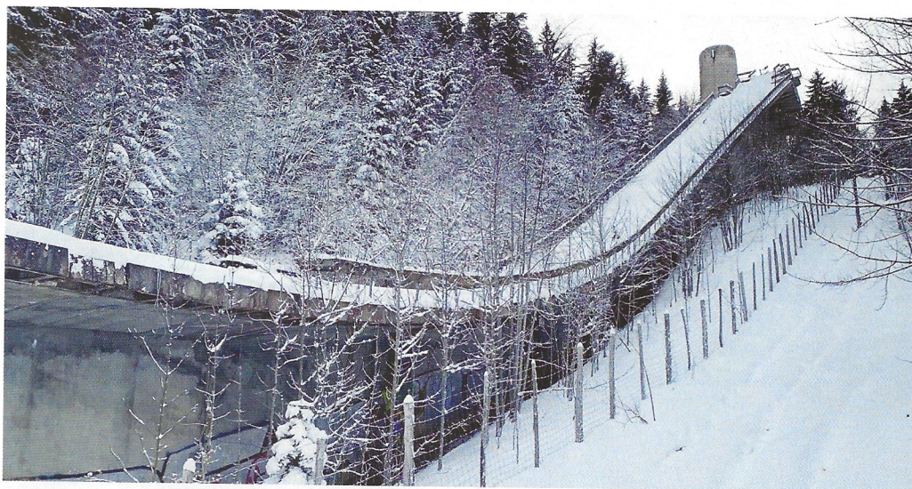
Le tremplin construit à l'occasion des JO de 1968 est à l'abandon depuis des dizaines d'années.
